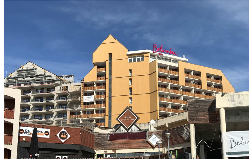
Travaux en cours avec extension à gauche
